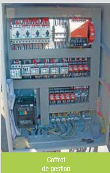
Le coffret électrique de gestion du chargement péniche permet d'utiliser dans des conditions optimales l'équipement.
